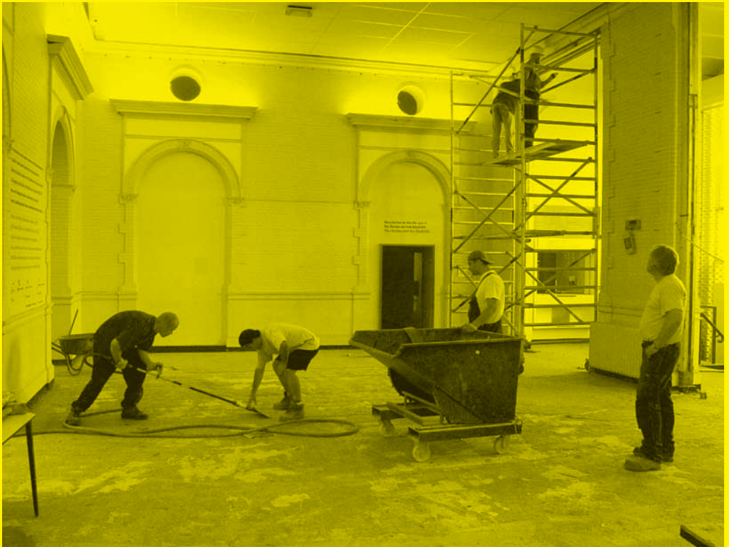
Werkzaamheden in de hal aan de Paulus Potterstraat
