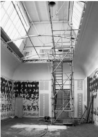
Daglicht in de omloop bij de trap en op zaal
